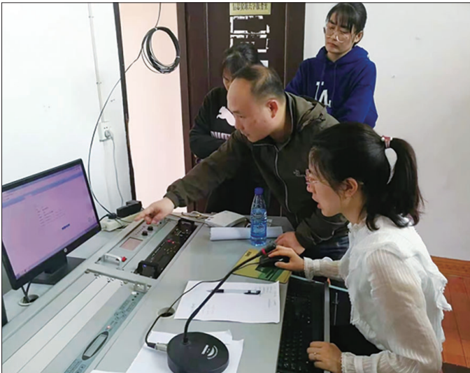
党的二十大召开前夕,绥宁县组织专业队伍深入17个乡镇播控平台,争分夺秒抢修维护“村村响”,确保党的声音传遍苗乡侗寨。此次抢修维护行动主要对机房播出设备、控制台各播出软件进行检查、维护检修、更新,并安排专人在党的二十大新闻播出重点时段进行值守,打通“村村响”安全播出“最后一公里”。图为10月13日,专业人员在乡镇播控平台开展测试。邵阳日报记者 袁光宇 通讯员 袁学龙 摄影报道
