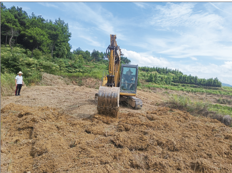
大祥区罗市镇盘比村积极响应耕地抛荒治理工作要求，组织干部群众大力推进耕地抛荒复垦，致力保障国家粮食生产安全。此次该村共需整治抛荒面积35.6亩，截至目前已完成复垦32亩。图为7月22日的复垦现场。邵阳日报记者 伍洁 通讯员 杨松华 摄影报道
