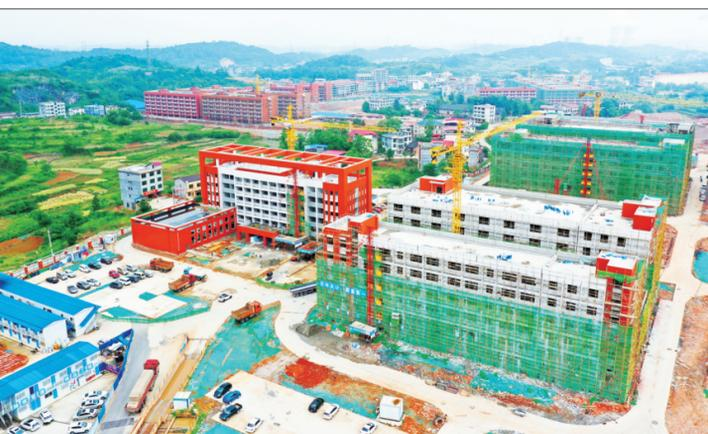
湘中职业技术学院项目位于大祥区雨溪街道学院路旁,规划占地面积486亩,总投资近13亿元。目前,该项目土石方工程已基本完成,挡土墙及围墙施工完成总量的95%,室外道路工程完成总量的90%。办公综合楼、男生宿舍、教工宿舍、女生宿舍及食堂已完成主体施工,正在进行装饰装修工程施工。
