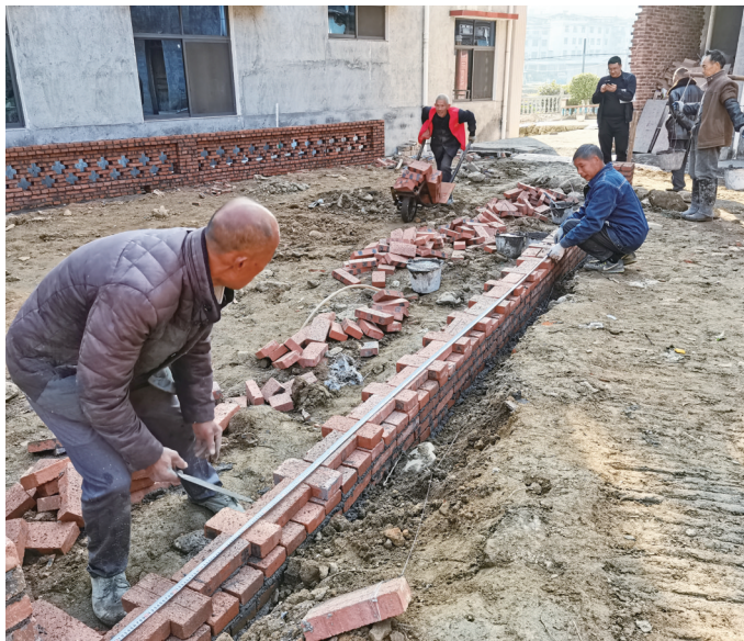
金石桥镇黄金井村劳务公司的务工人员在施工。
