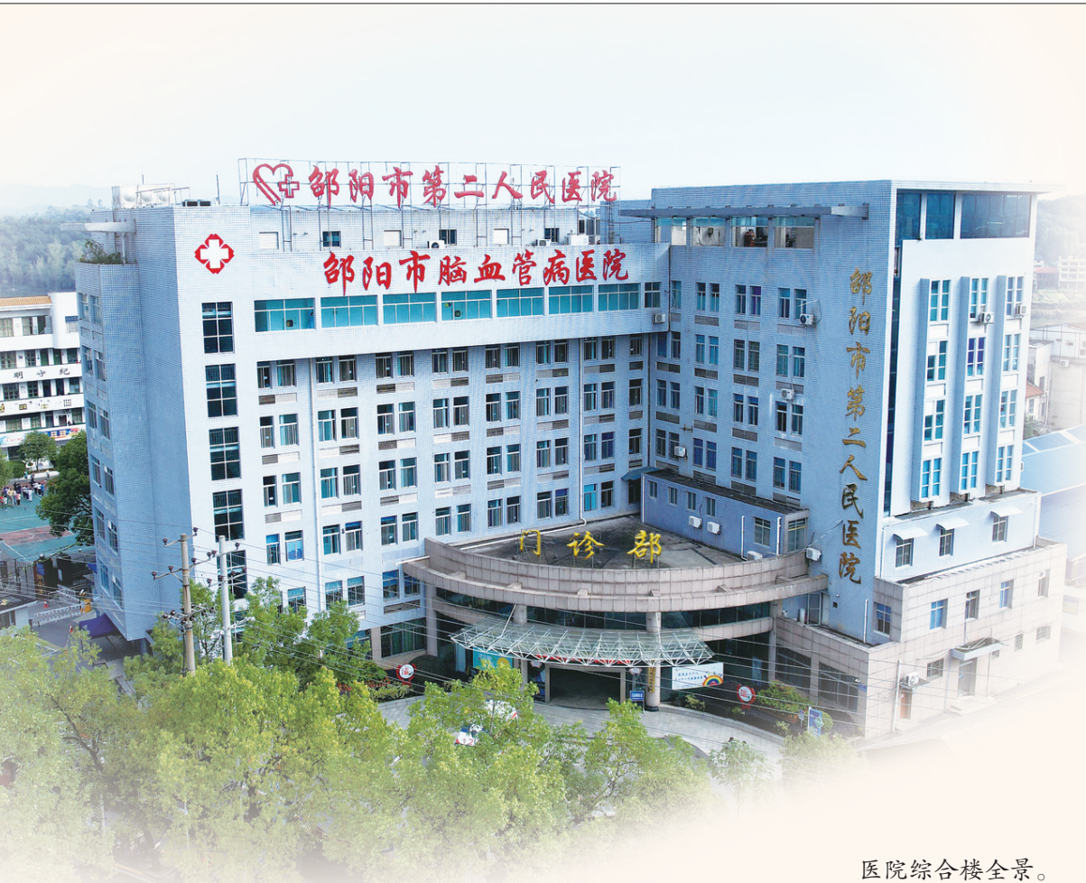
医院综合楼全景。
