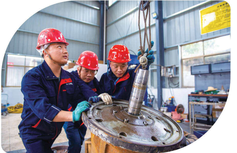
▲市排水管理所工作人员配合作业,吊装潜污泵。
