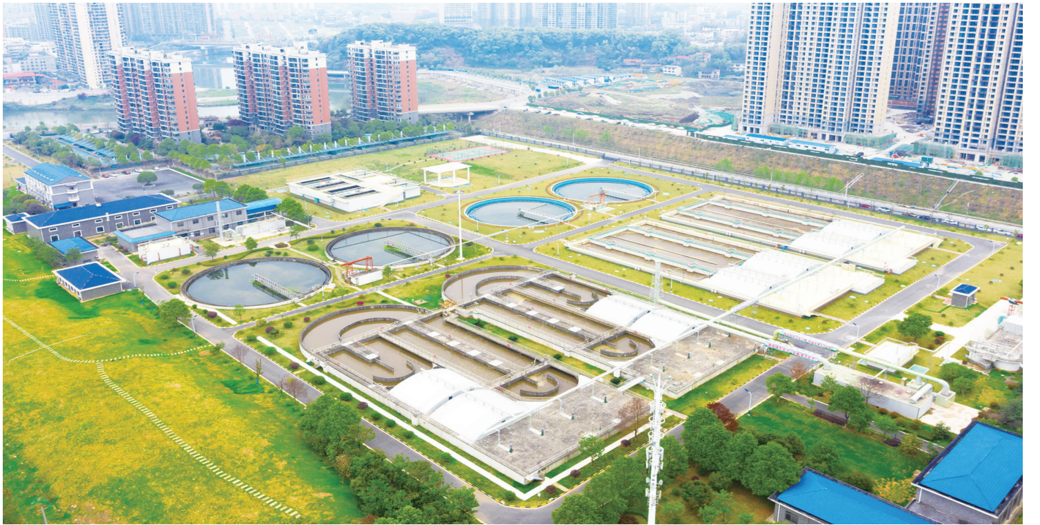
▲经过提标改造、扩建后,市区红旗渠污水处理厂焕然一新。
