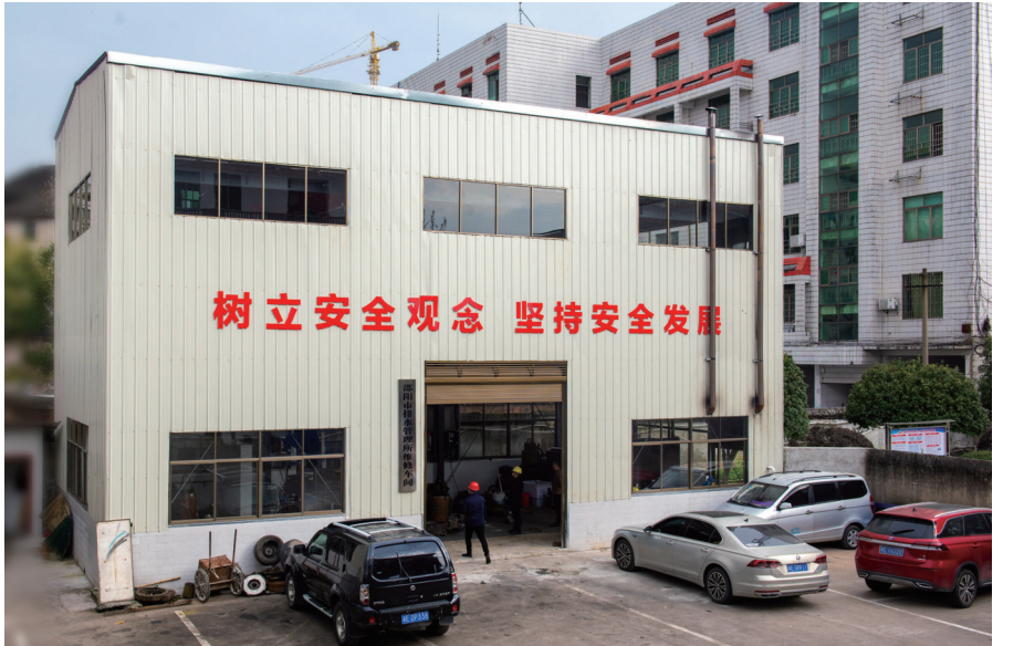
▲设施完备、可“一站式”快速完成维修任务的市排水设施维修中心。
