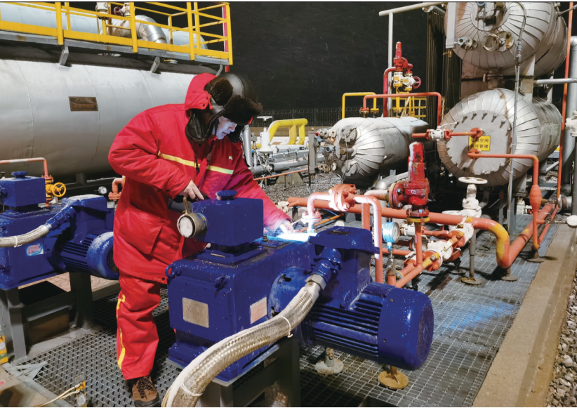
图为员工在检查储气库装置(2021年2月28日摄)。新华社发(大港油田供图)
