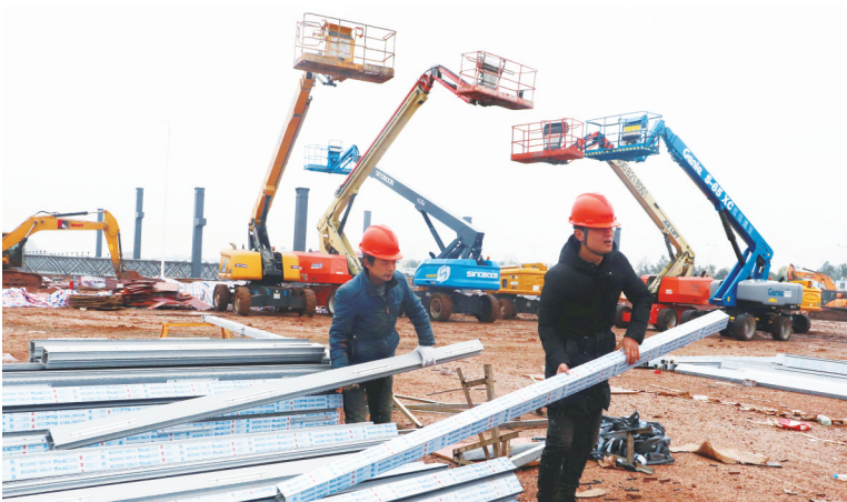
加紧搬运建筑材料。
