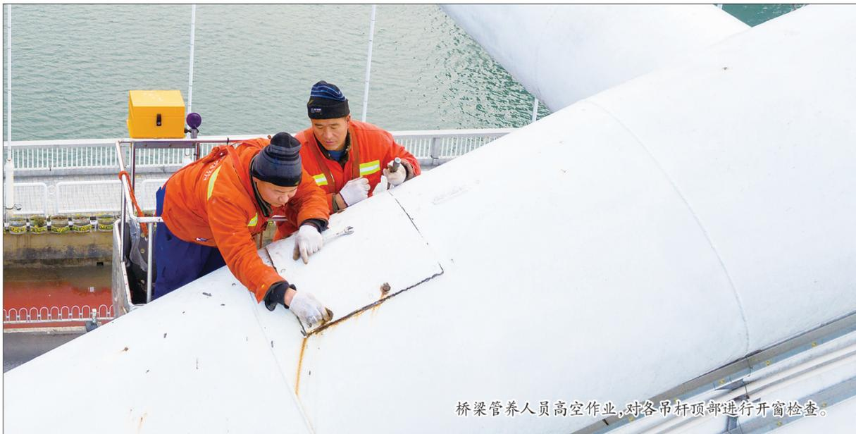
桥梁管养人员高空作业,对各吊杆顶部进行开窗检查。
