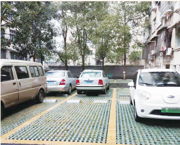
新建成的生态停车坪。邵阳日报记者 罗俊 摄
