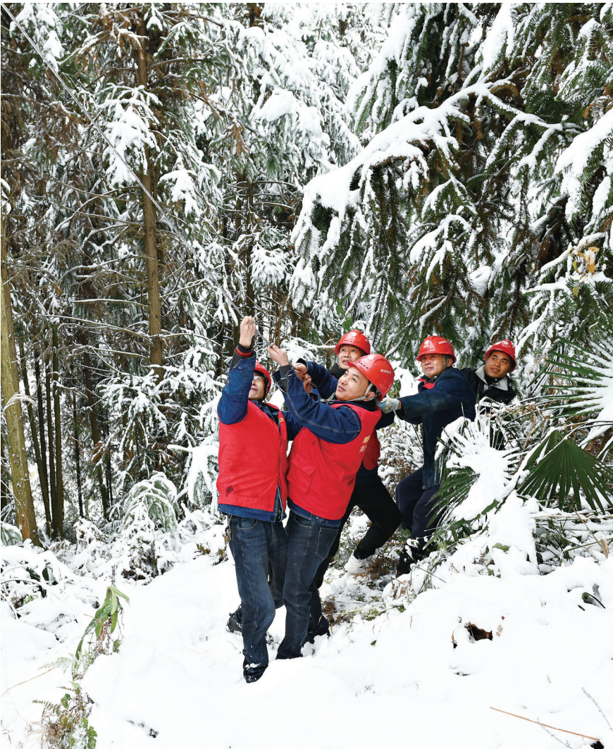
12月27日，洞口县山门镇清水村，国网洞口县供电公司山门供电所员工正在抢修因覆雪倒树引发的10千伏高压线路故障。近日，该县迎来一轮低温雨雪冰冻天气，当地供电公司迅速开展冰雪情况监测、防冰融冰等工作，确保电力线路畅通、供电正常。 邵阳日报通讯员 滕治中 肖永春 摄影报道
