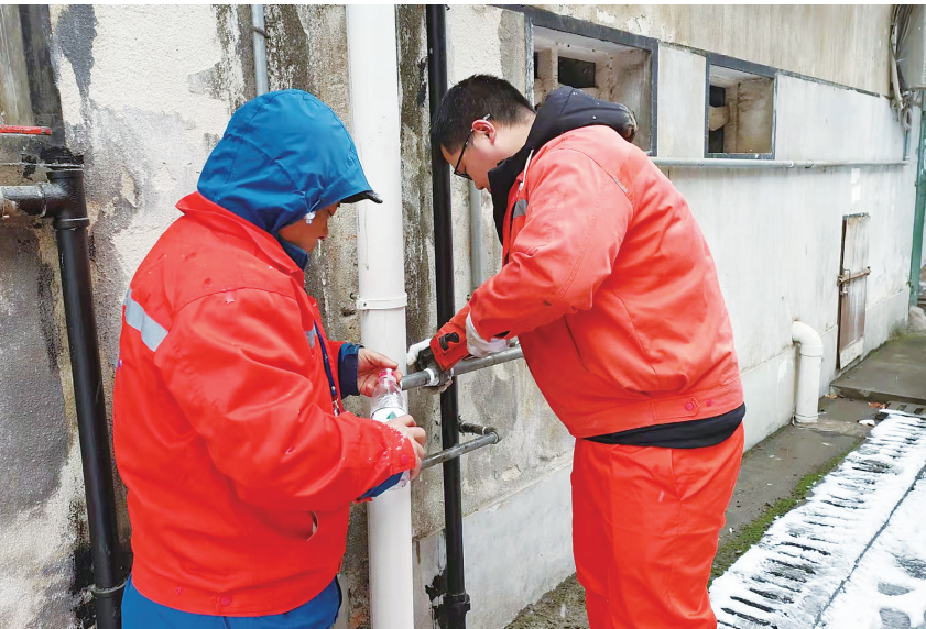
12月26日，大祥区城西街道湘印机社区，市燃气公司工作人员顶风冒雪对小区管道进行检修排险。
