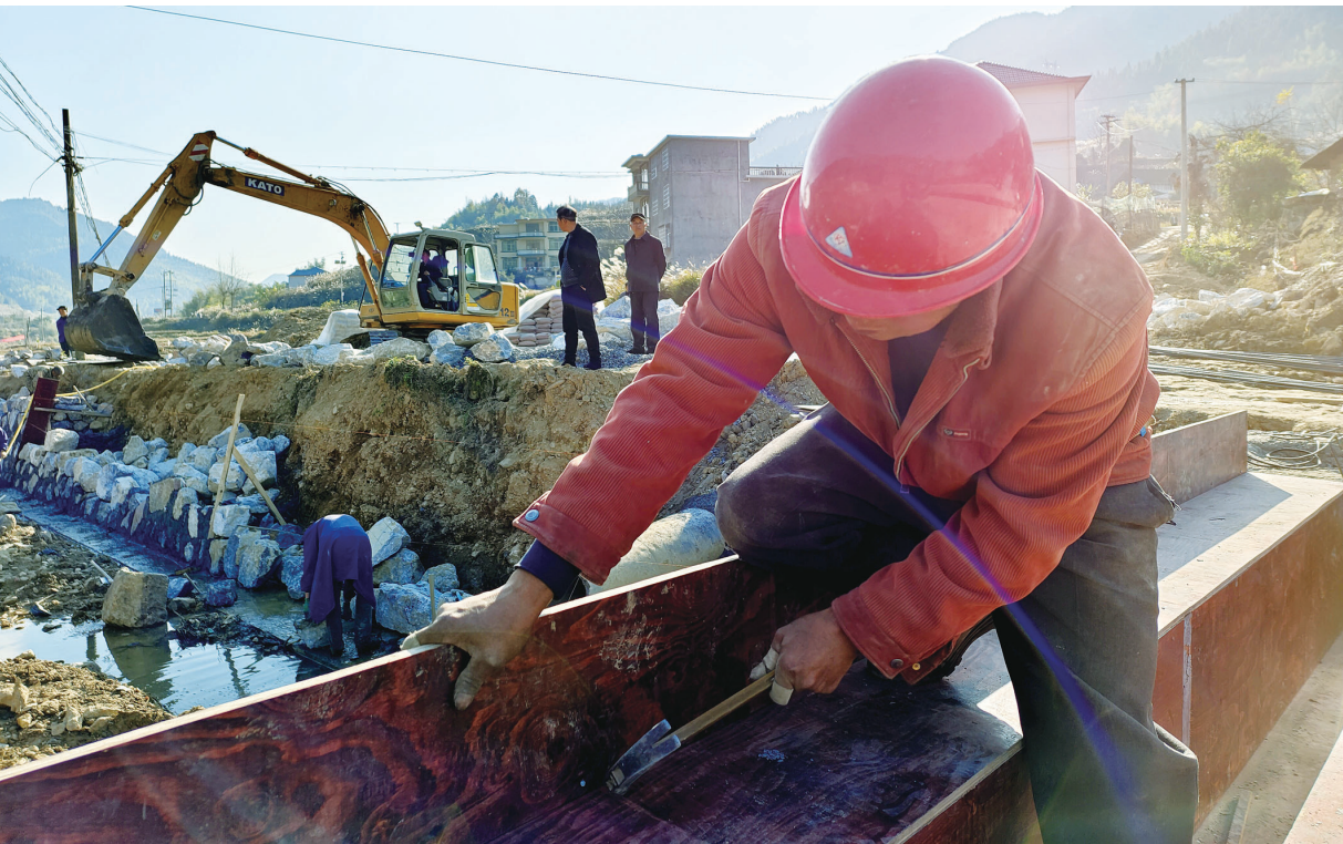
12 月 20 日,城步苗族自治县儒林镇塔溪村,施工人员在河道上进行修筑河堤和架设桥梁等作业。 今冬以来,城步苗族自治县将河流生态治理与高标准农田建设相结合,通过完善水利配套设施,大力提升基本农田的抗灾能力,促进农业增效、农民增收,助推乡村振兴。 邵阳日报通讯员 严钦龙 摄
