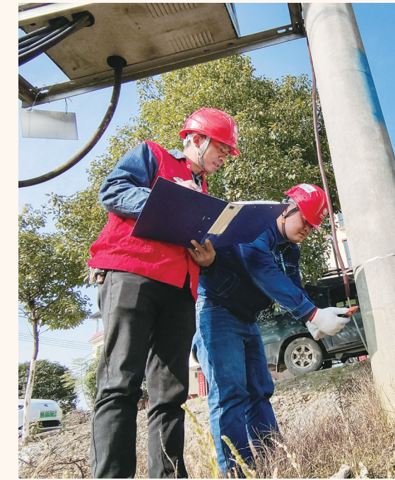
隆回雨山供电所工作人员在进行配电线路设备检修。
