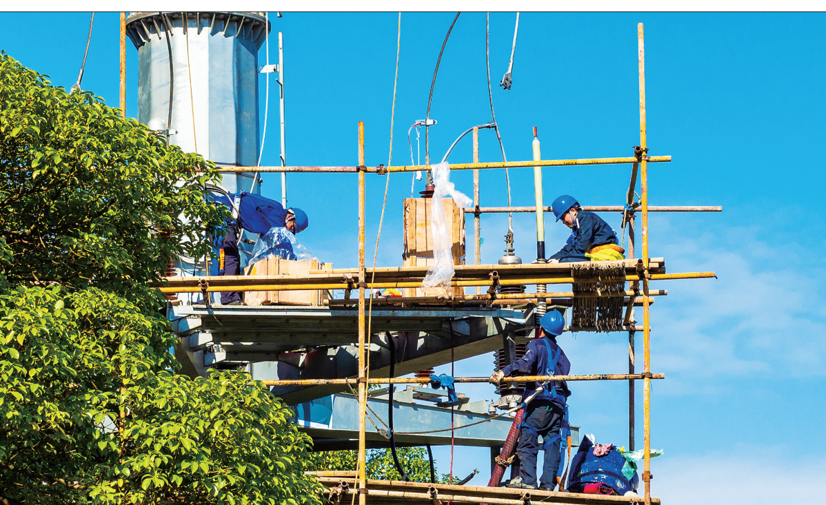
11月23日，市区邵水西路，国家电网邵阳供电公司专业技术人员在线路终端杆上进行高空作业。近日，该公司抓住晴好天气对市区跨邵水河的电缆110kV宝六双线索实施作业，将邵水西路B2终端杆和邵水东路B1端杆的电缆终端头进行更换，通过升级产品质量，进一步确保市区供电安全。 邵阳日报记者 唐明业 摄
