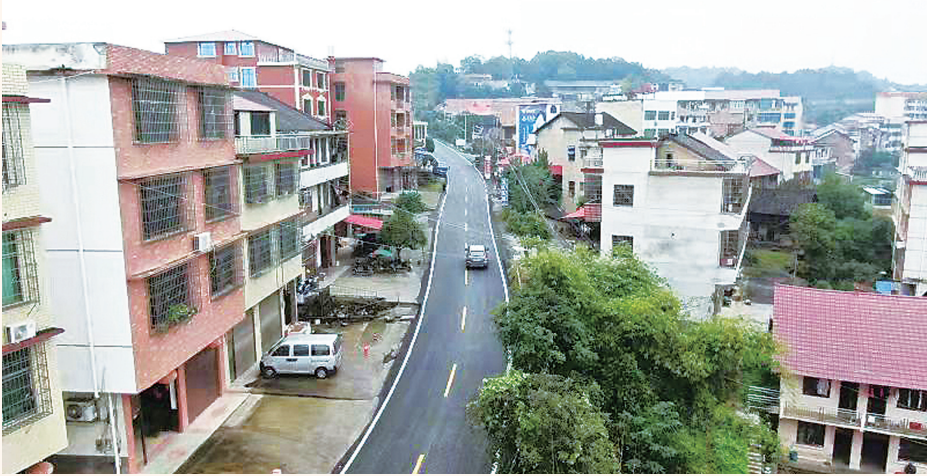
双清区莲荷片区旅游资源产业路全长10公里,今年将完成4.7公里,目前金台至渔溪桥段2.48公里沥青路面已经完工,整个道路建成将优化农村公路网络,助力乡村旅游业发展。
