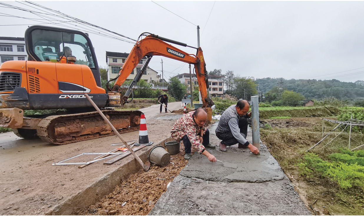
11月4日，双清区交通运输局组织施工人员对莲荷片区旅游资源产业路杨柳段加快施工进度。该路段路面宽5米，全程铺设沥青路面，计划在本月底完工。该公路提质改造工程完成后，将全面提升莲荷片区旅游出行环境，促进旅游消费。 邵阳日报记者 伍 洁 通讯员 唐美玉 刘兴富 摄影报道
