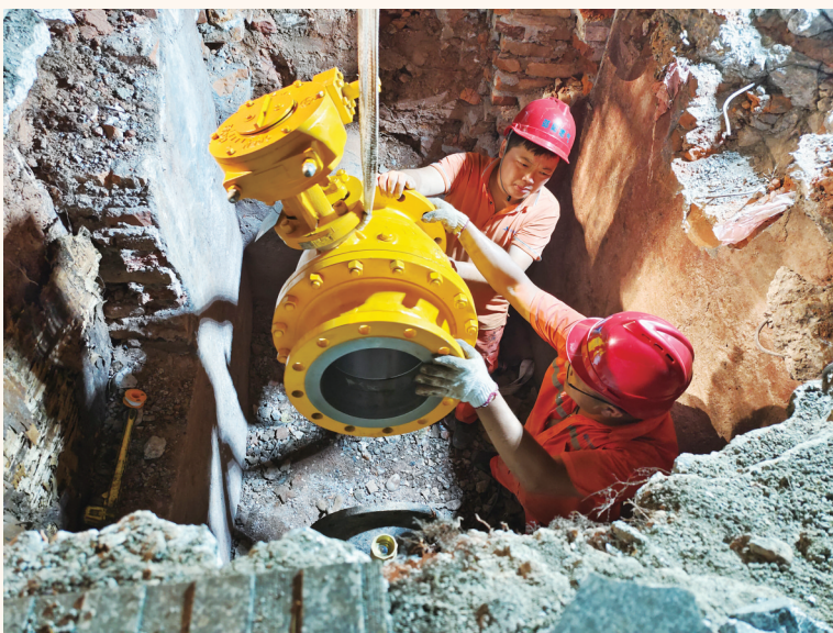
工作人员在新邵县城加班加点抢修。
