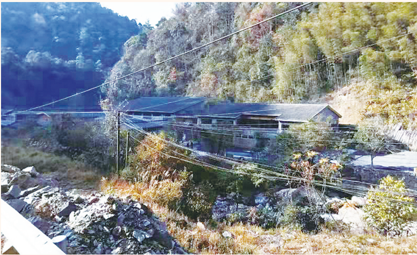
绥宁县寨市苗族侗族乡时光里民宿非法占用耕地房屋拆除前。
