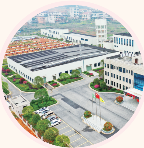
建成投入使用的邵东兴隆工业区污水处理厂。 申兴刚 摄
