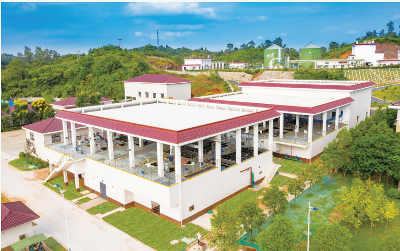
◀在扩建和提标改造中，江北污水处理厂新建了中间提升泵站、高效沉淀池、反硝化深床滤池等一系列工程。
