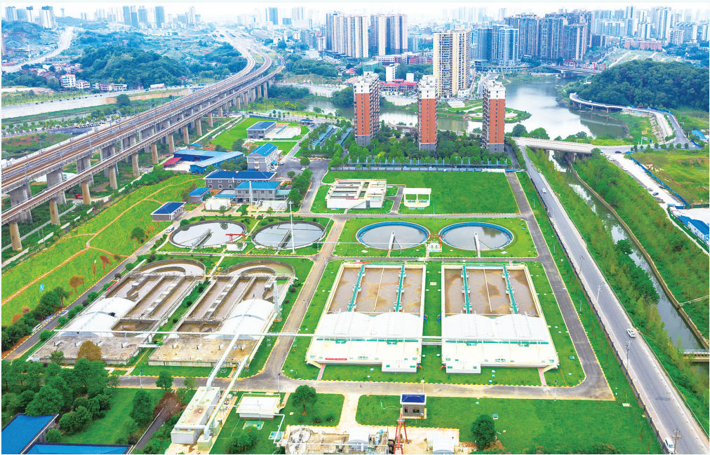
扩建和提标改造后，红旗渠污水处理厂厂区焕然一新。
