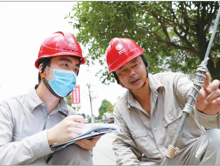
8月30日,国网新邵县供电公司配电班负责人将新进职工带到10千伏王蔡线下,手把手地讲授电力拉线制作要点。
