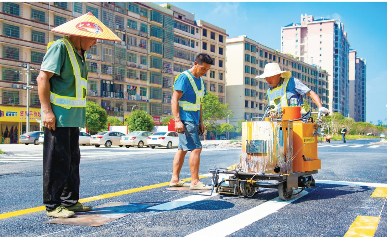
9月3日,北塔区雪源路(北塔路—西湖北路),道路划线施工进入扫尾阶段,即将迎来全线通车。该路全长约1075米,道路红线宽20米,其中车行道宽2×6米。
