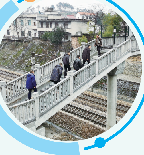
在袁家村新建的人行天桥,让群众跨越铁路线更安全。邵阳日报记者 刘波 摄
