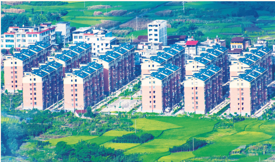
新宁县国营林场易地扶贫搬迁安置点。
