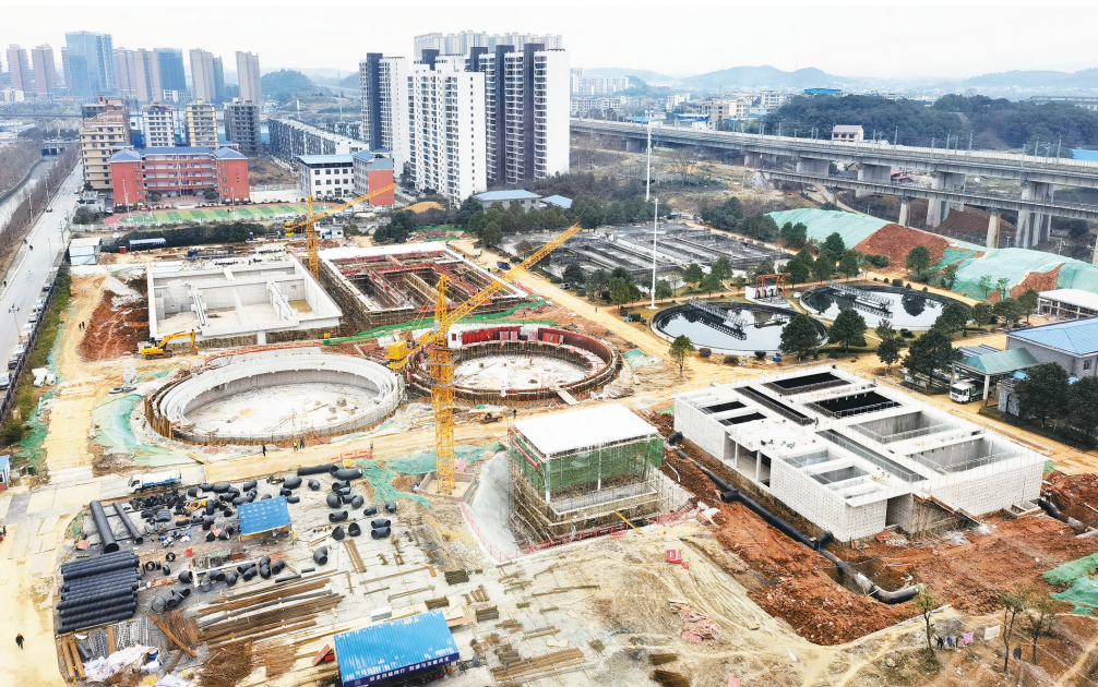
红旗渠污水处理厂提标改造工作正在如火如荼进行。
