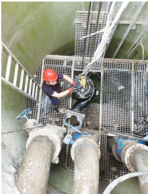
市排水管理所工作人员在安装经过检修的潜污泵。
