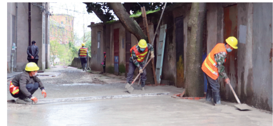
老旧小区改造工程加速推进。
