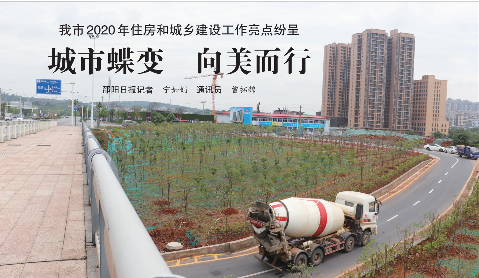
▲新修建的雪峰桥便道及其周边的绿化“补天窗”工程。
