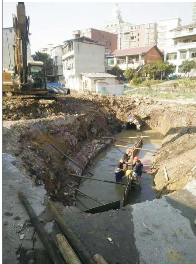
1月19日,施工人员对大祥区城西街道樟树坳社区李家坳通组道路路基进行维修加固。上月底,樟树坳社区安全专干在进行安全生产风险地毯式排查中,发现该路段路旁经常有汽车冒出,经勘探人员钻探检查,原是水泥路基已大面积塌陷。经大祥区政府、城西街道协调,市资江南路建设指挥部组织施工人员进行紧急抢修,确保沿途群众安全出行。
