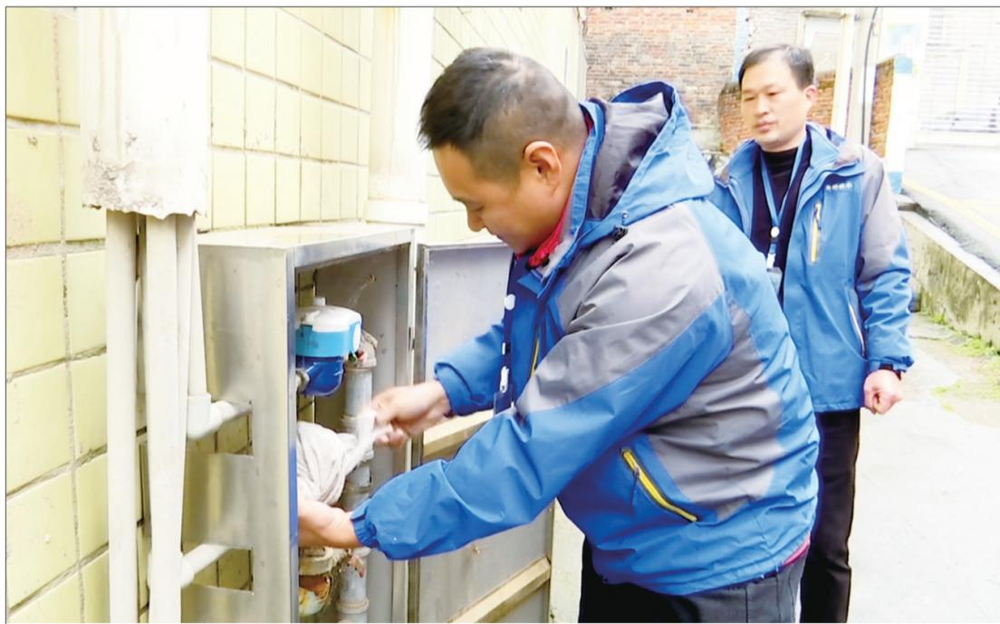
12月14日,新邵县自来水公司员工正在对裸露室外的水表进行保温包扎。近日,该公司启动低温雨雪应急预案,组织多支应急小分队对居民供水管道和水表开展巡查和维修抢险工作,同时紧急采购了2000套水表及配件,以全力保障居民供水安全。邵阳日报记者 杨敏华 通讯员 胡金国 摄影报道
