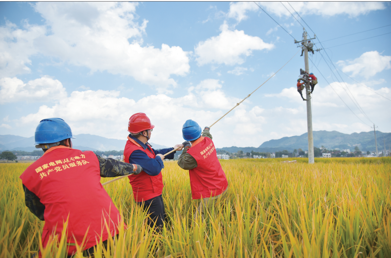
11月17日至19日，隆回县供电公司高坪供电所对10千伏高镇线、高颜线开展集中检修工作，进一步提升供电设备健康运行水平。图为11月18日，施工人员在施工现场开展金具安装、放线等工作。
