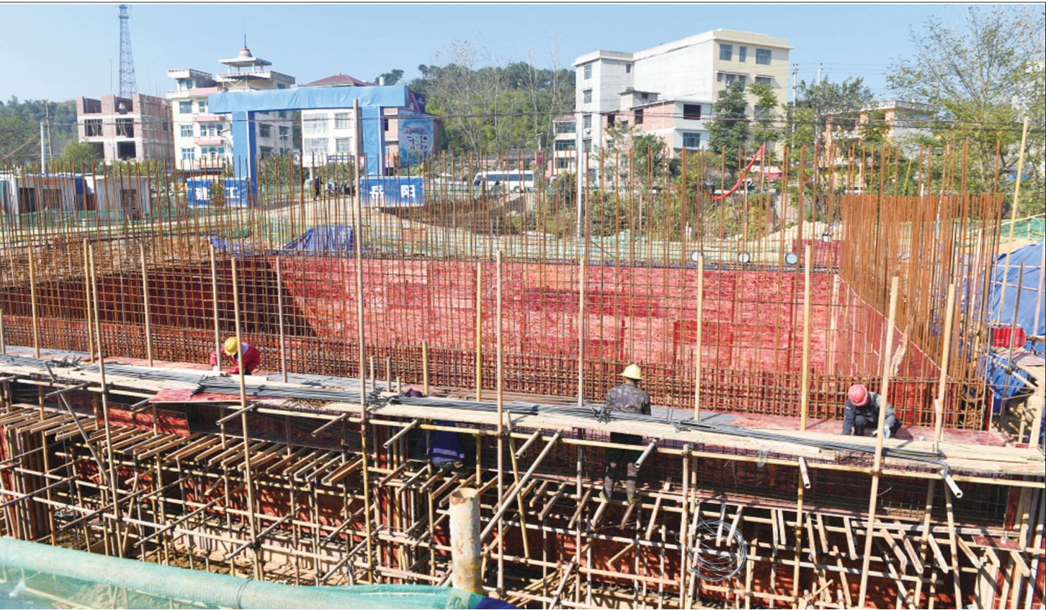
城步西岩污水处理厂项目位于该县西岩镇北面古马桥地段,占地15.1亩,近期处理规模为每日2000吨,远期处理规模为每日4000吨。目前,该项目已进入主体结构施工阶段,收集管网已完成95%。图为11月13日,加紧施工中的西岩污水处理厂项目。 邵阳日报记者 申兴刚 摄
