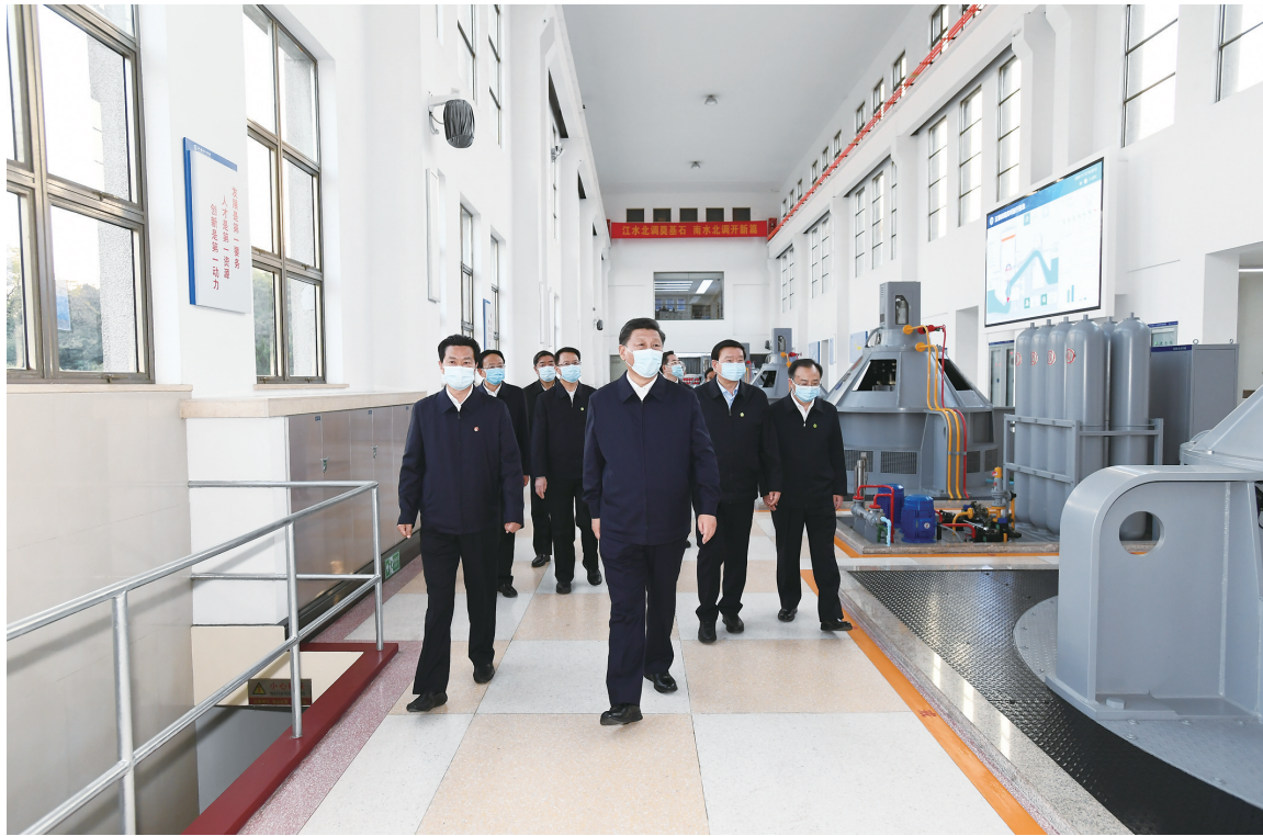
13日下午，习近平在扬州市江都水利枢纽第四抽水站，察看抽水泵运行情况。 新华社记者 谢环驰 摄
