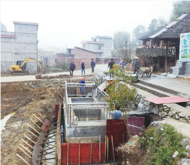
驻村帮扶工作队筹措资金为群众修缮水井。
