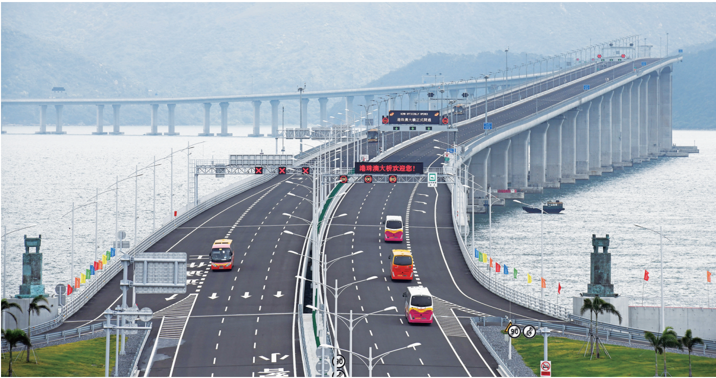
图为港珠澳大桥(2018年10月24日摄)。
