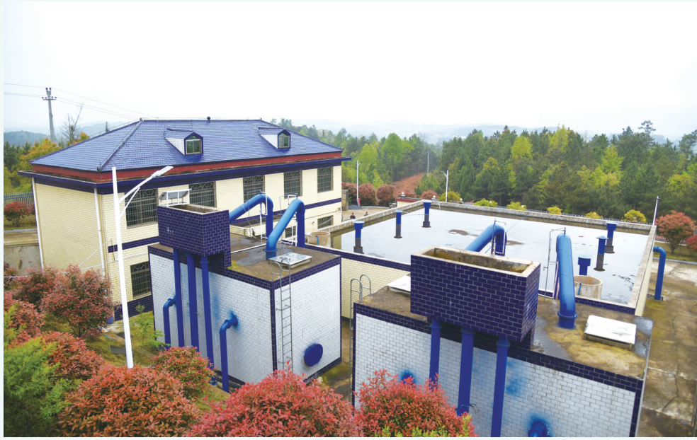
邵阳县谷洲镇集中供水工程。
