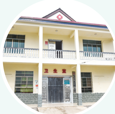
翻修一新的村卫生室。 邵阳日报记者 申兴刚 摄
