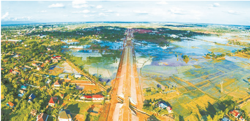
位于澜沧江—湄公河流域的中老铁路是中国“一带一路”倡议与老挝“变陆锁国为陆联国”战略对接项目,工程于2016年12月全面开工,目前,中老铁路隧道、桥梁和路基工程已完成超过90%,计划2021年12月建成通车。图为在老挝北部拍摄的中老铁路。新华社发
