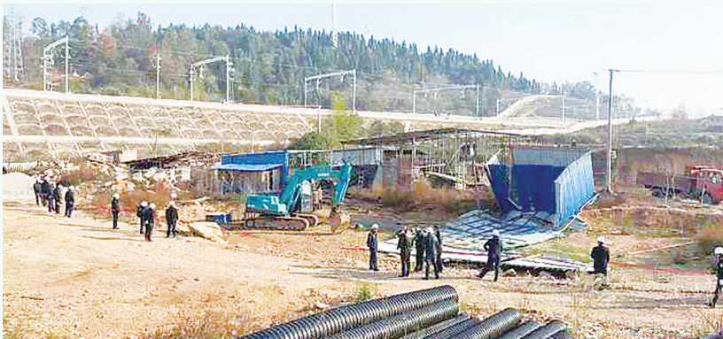
隆回县铁路安全环境整治办组织力量对邻近隆回火车站的桃花坪街道兴旺村隐患彩钢棚架进行拆除。
