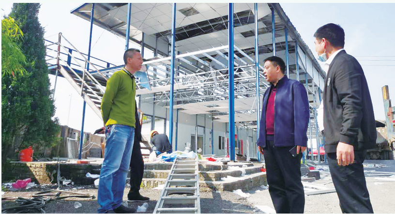
大祥区二、三、四级段长现场监督安全隐患点整治,加快彩钢瓦棚拆除进度。
