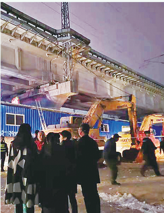
2019年11月,邵东市宋家塘怀邵衡铁路桥下的特大硬漂浮物拆除作业。
