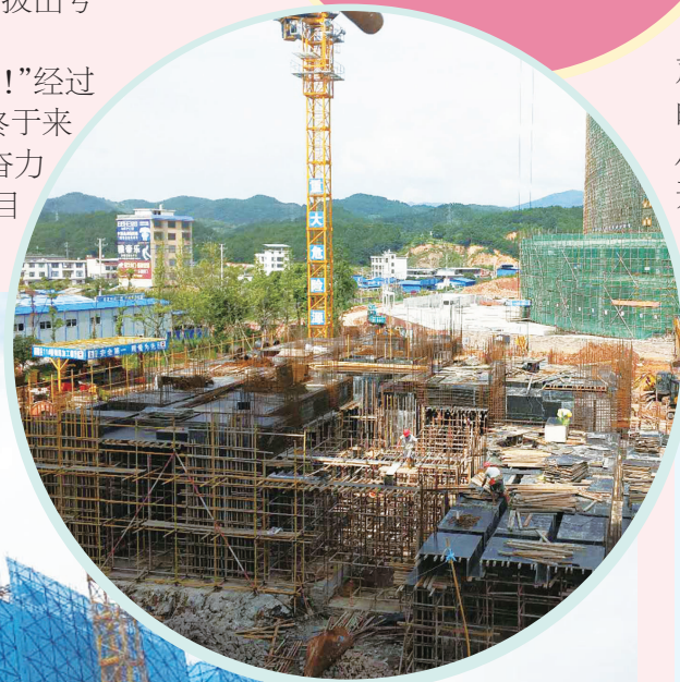
▲施工现场一片繁忙。
