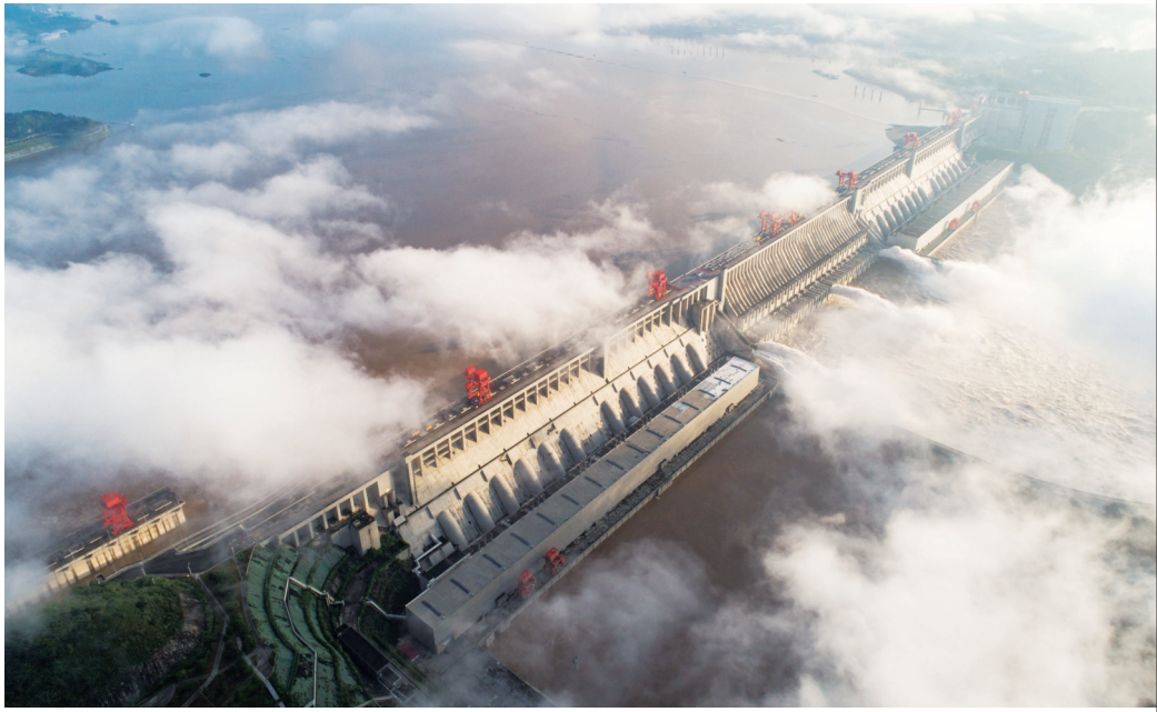
7月27日,长江三峡枢纽工程开启泄洪深孔泄洪(无人机照片)。新华社发(王罡 摄)
