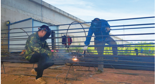
◀资江南岸防洪堤工地,施工人员进行焊接作业。
