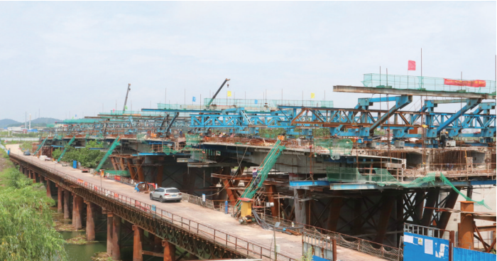
◀施工中的桃花桥。
