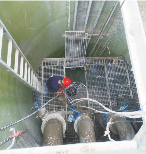
潜污泵被安放进十余米深的污水泵坑中。
