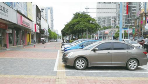
市区敏州东路人行道改造工程项目5月底完工。改造后，该路段人行道采用彩色透水砖取代以前的花岗岩板砖，新增了部分停车位以及几处非机动车停放区域，缓解沿线停车位紧张局面。邵阳日报记者 伍洁 摄
