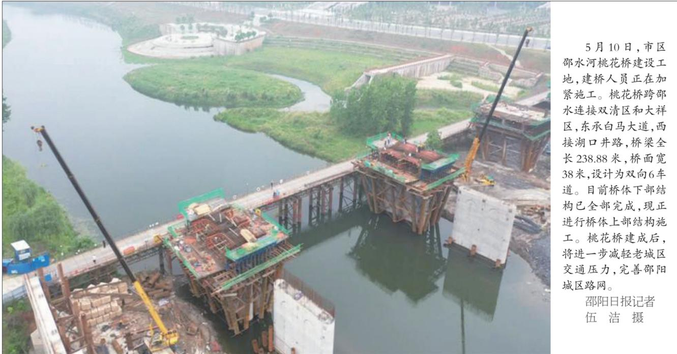
5月10日,市区邵水河桃花桥建设工地,建桥人员正在加紧施工。桃花桥跨邵水连接双清区和大祥区,东承白马大道,西接湖口井路,桥梁全长238.88米,桥面宽38米,设计为双向6车道。目前桥体下部结构已全部完成,现正进行桥体上部结构施工。桃花桥建成后,将进一步减轻老城区交通压力,完善邵阳城区路网。
