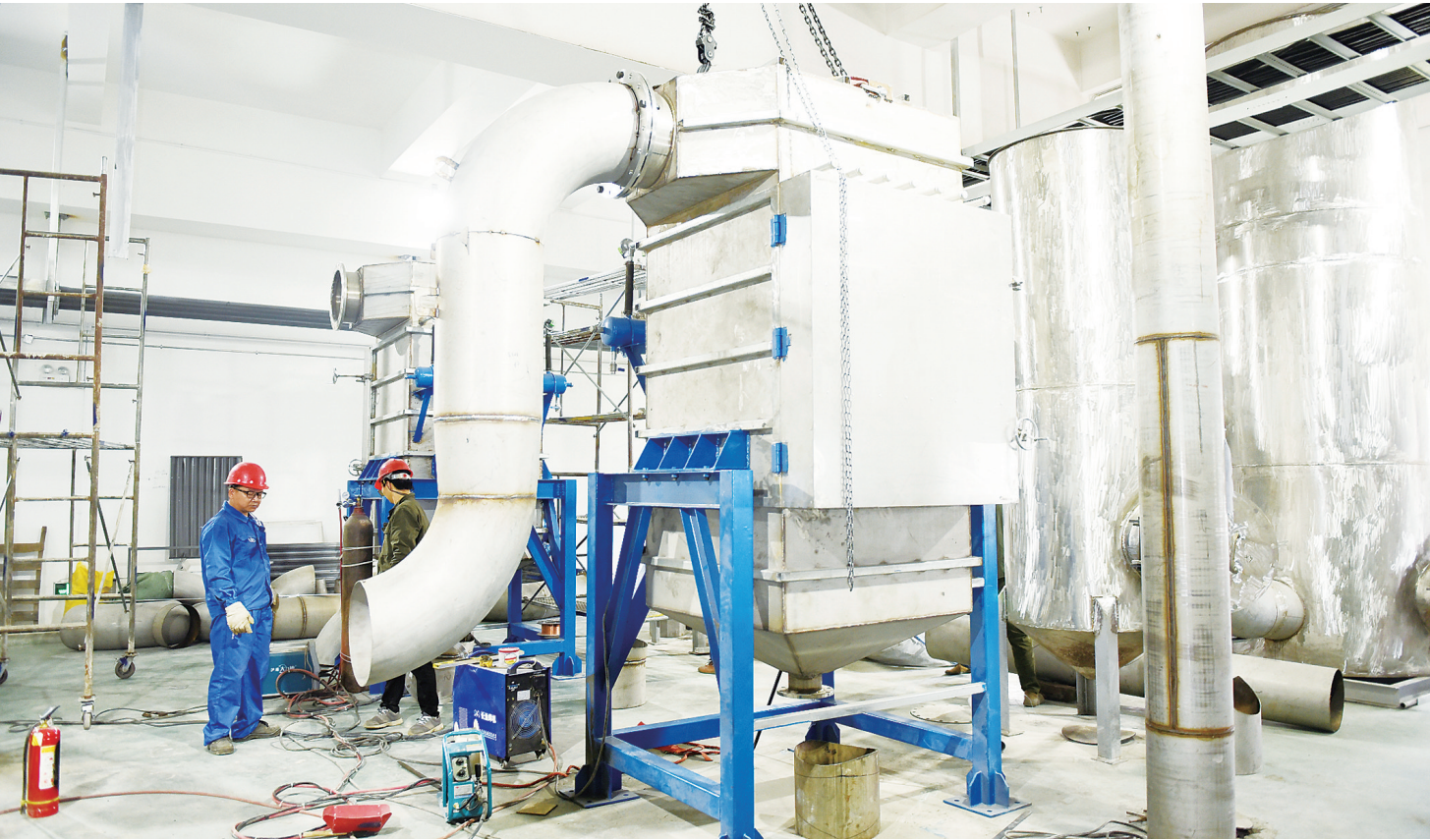
邵阳经开区的彩虹集团（邵阳）特种玻璃有限公司G7.5盖板玻璃智能化工厂建设项目总投资20亿元，占地面积154亩。图为5月9日，该公司第二条生产线正在紧张建设施工。
