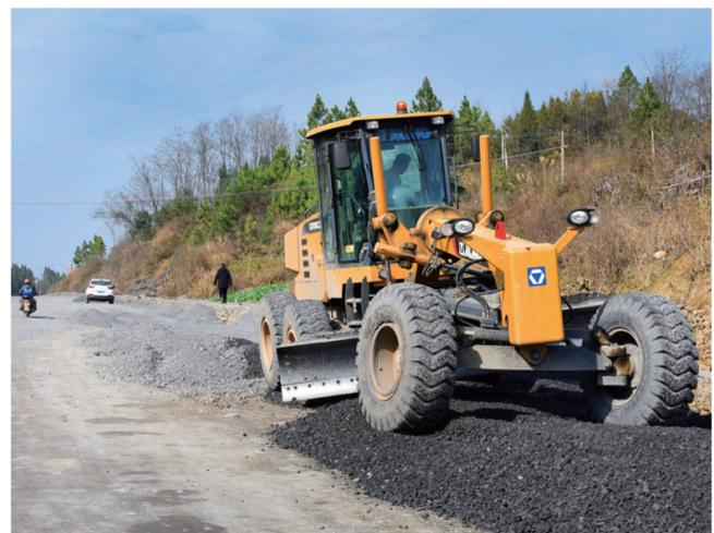
▲ 上月27日下午,隆回县鸭嘴公路周旺至滩头段,施工人员正在铺设碎石层。提质改造后的鸭嘴公路滩头至周旺段铺设沥青路面,全长12公里,路基宽12米,预计今年8月完成改造施工。图为当日施工现场。
