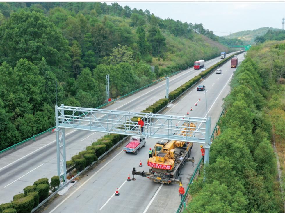
10月12日,我市高速公路完成ETC门架吊装任务,为12月底前完成全国联调联试打下坚实基础。ETC门架系统是一种类似交通探头的设施,架设在高速公路上方,替代原有的省界收费站的功能,确保在车辆快速行驶的同时实现精准计费。
