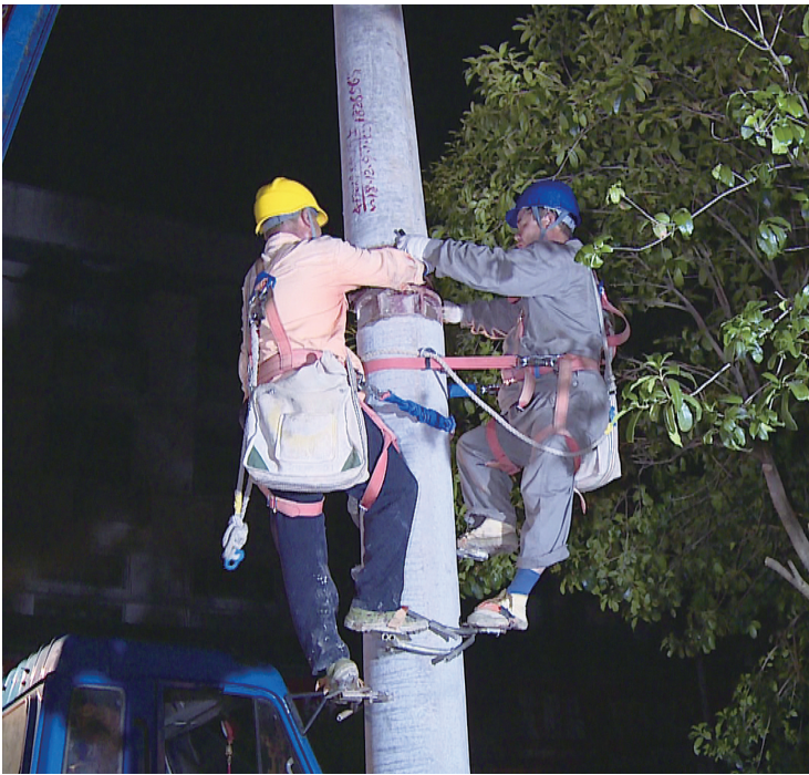
供电员工在夜色中登杆作业。
