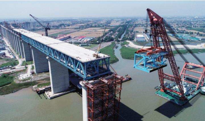
施工人员在使用浮吊吊装、架设沪通长江大桥首个超千吨大节段钢梁(2018年6月1日无人机拍摄)。
