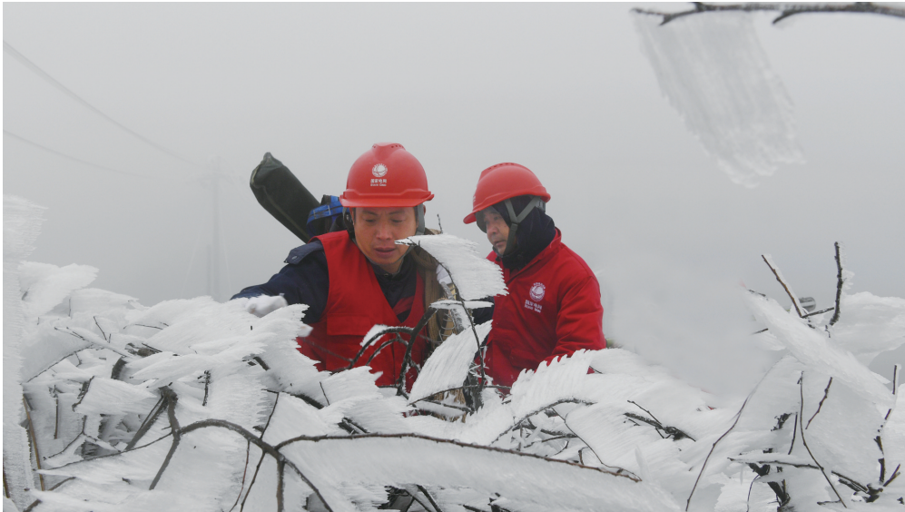
茅坪供电所所长郭宗成(左)带着安全员杨焕池踏冰卧雪特巡保供电。
